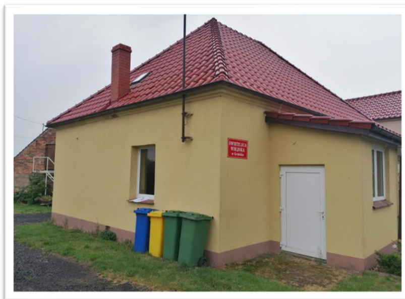
Fot. 21. Budynek świetlicy przed remontem
