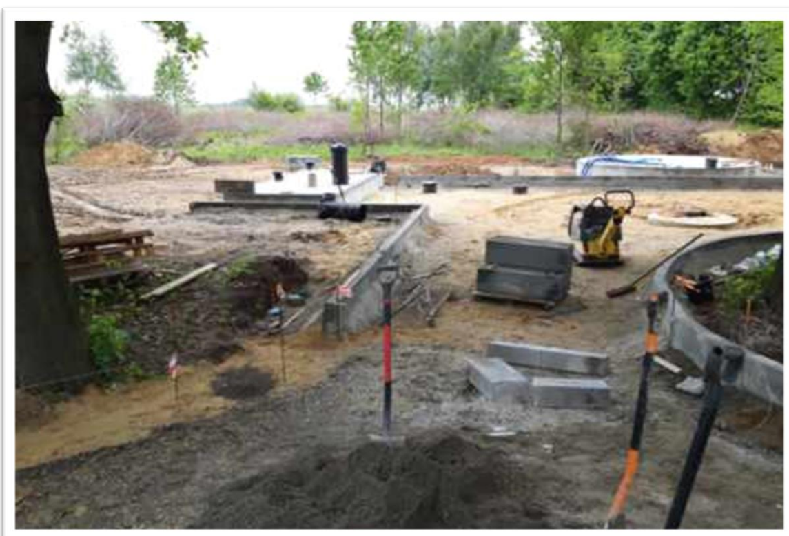
Fot. 20. Teren przepompowni w Korytowie podczas realizacji zadania
