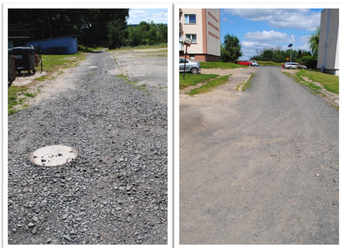
Fot. 13. i 14. Droga w Wierzchowicach przed przebudową
