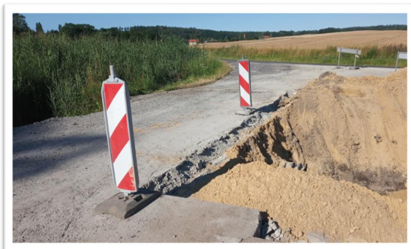
Fot. 4. Droga w trakcie remontu
