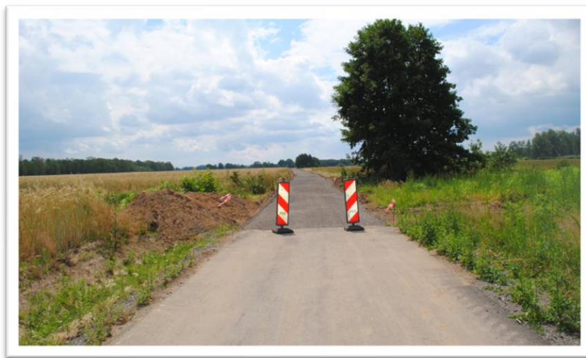
Fot. 6. Droga w Koźlicach w trakcie przebudowy
