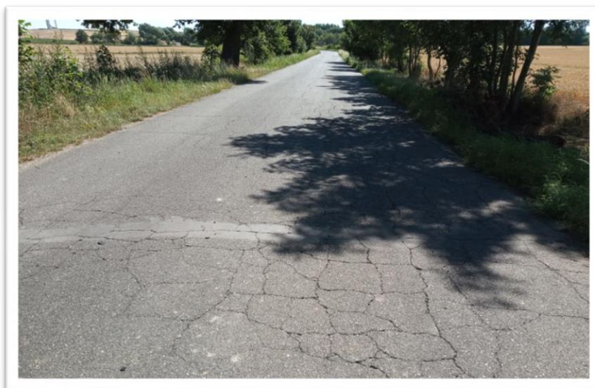
Fot. 10. Droga Śrem-Witanowice przed inwestycją
