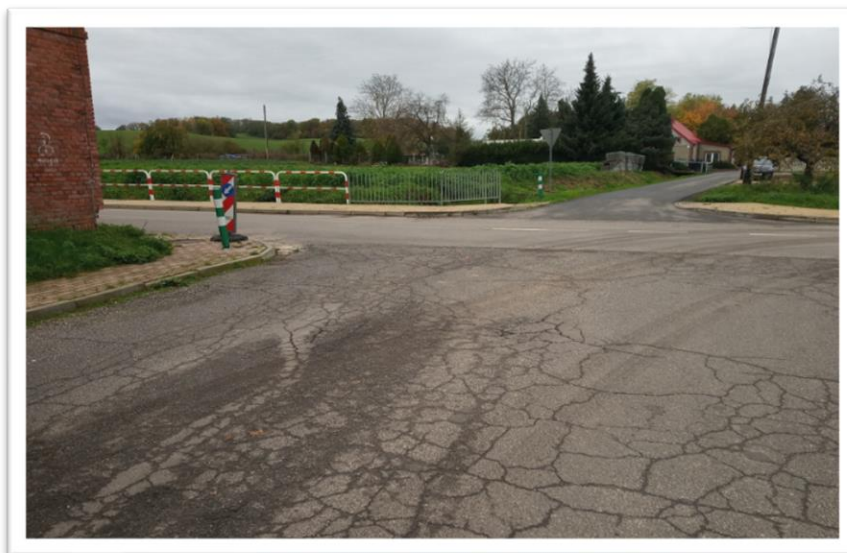
Fot. 11. Droga w miejscowości Witanowice przed remontem
