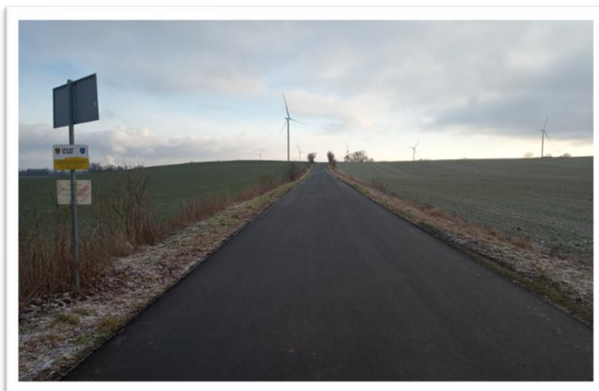
Fot. 12. Droga dojazdowa do gruntów rolnych po remoncie
