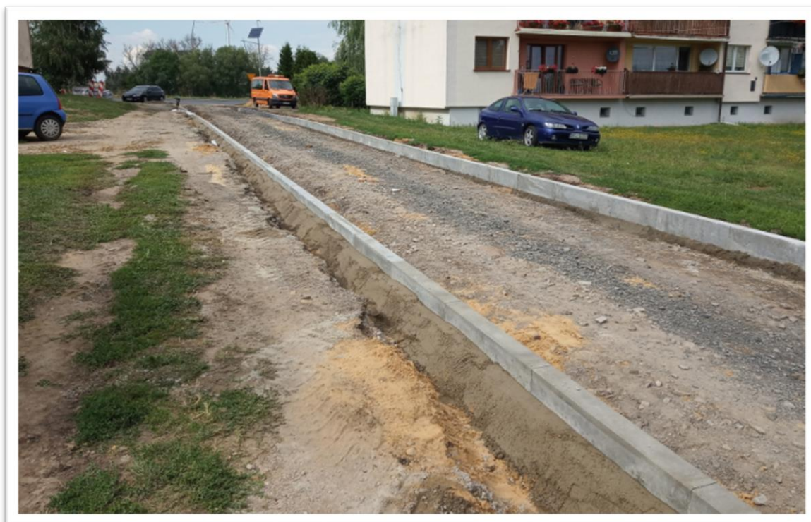
Fot. 15. Droga w Wierchowicach w trakcie przebudowy
