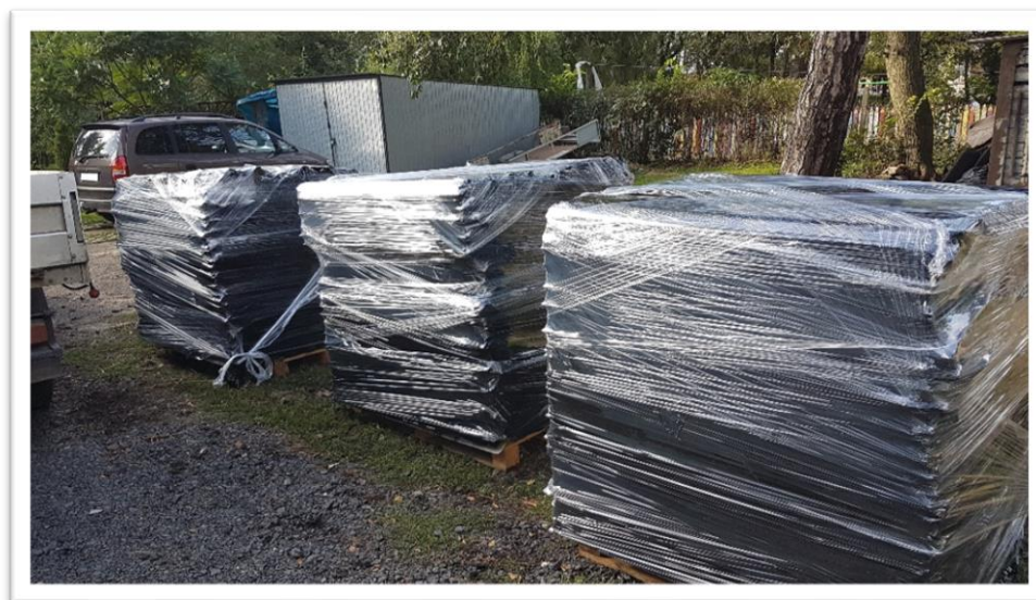
Fot. 37. Przygotowane do odbioru płyty cementowo-azbestowe
