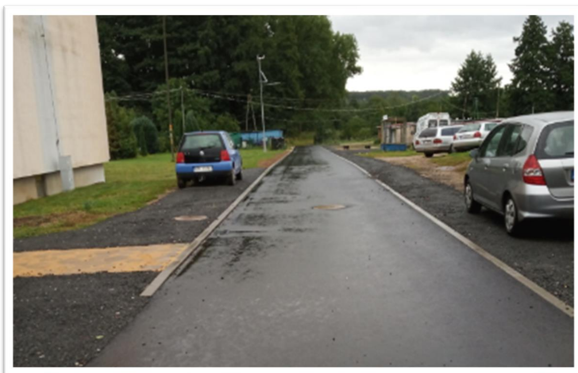
Fot. 16. Droga w Wierchowicach po przebudowie
