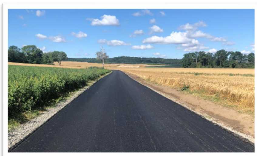
Fot. 5. Droga w trakcie remontu
